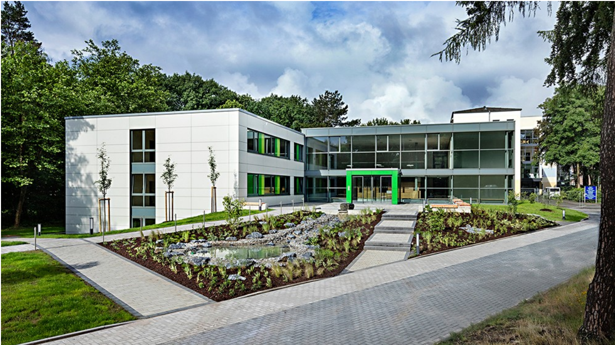
Zentralgebäude der LWL-Klinik Marl-Sinsen mit Empfang und Ambulanz
